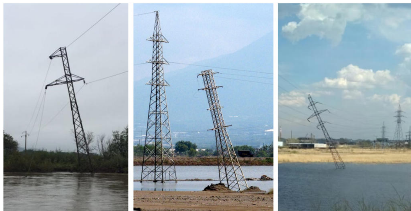
Рис. 1. Влияние грунтового основания на опоры ВЛ
